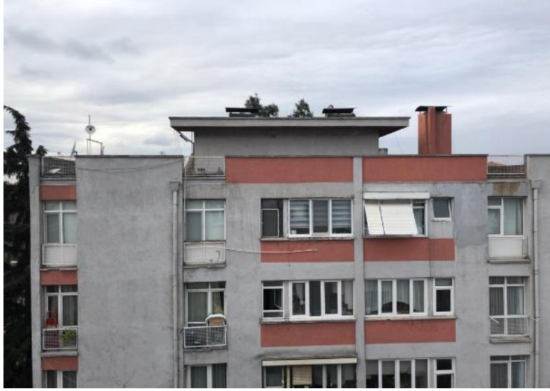
Foto 10: 5 Katlı Blok Çatı Terası
