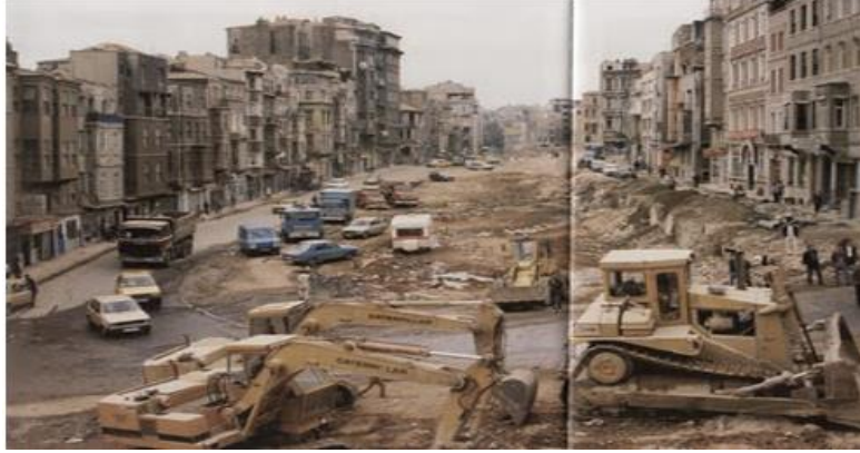
Fotoğraf 20: Tarlabası Bulvarının Açılması için Yapılan Yıkım Çalışmaları (1986) 52
