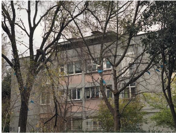
Foto 9: 3 Katlı Blok Çatı Terası
